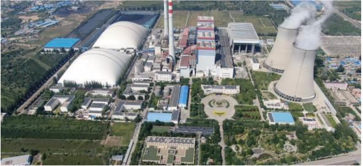
一期、二期工程
