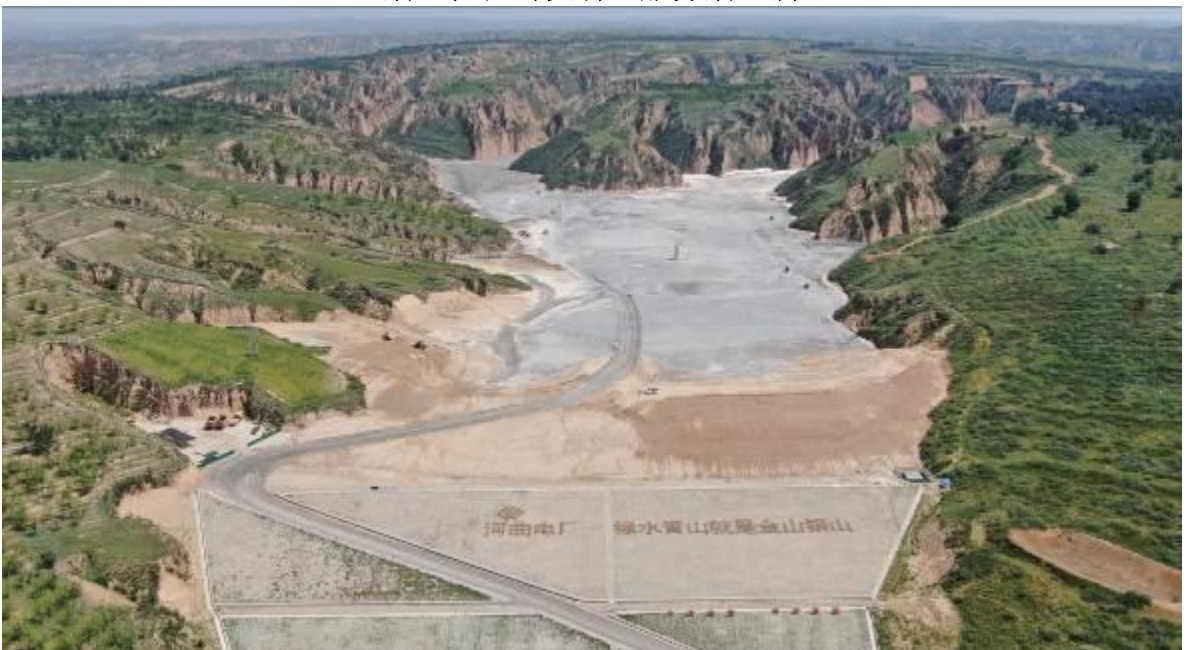
二期工程丰子沟灰场（填沟造地）
